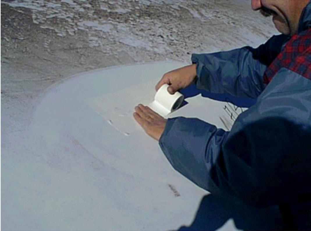
Figura 5. Fechamento dos orifícios produzidos pela retirada de amostras.
